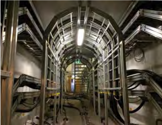
Hyxal-Alu-Kabelpritschen: Die hohe Festigkeit des Materials und das geringe Eigengewicht ermöglichen hohe Belastungen und große Stützweiten
