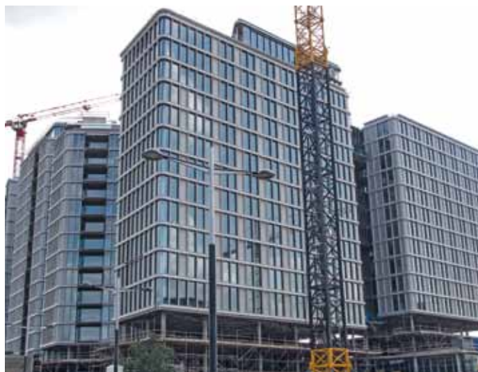
Auch beim Hotel- und Wohnanlagen-Großprojekt am Wiener Hauptbahnhof wird Unterflurtechnik aus dem Hause ROWA-MOSER eingesetzt
