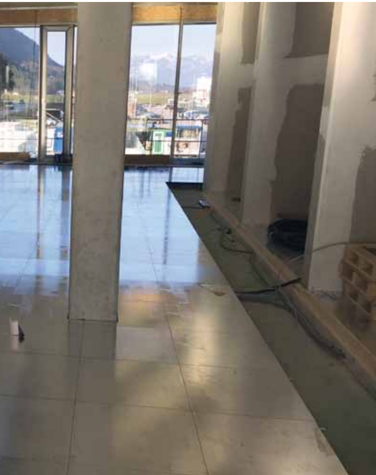
Bei Pharmaproduzent Sandoz in Langkampfen stehen 4.500 m 2 Doppelboden samt Belägen aus dem Hause Rowa-Moser im Einsatz sowie sämtliche Unterflurlösungen und Kabeltrassen
