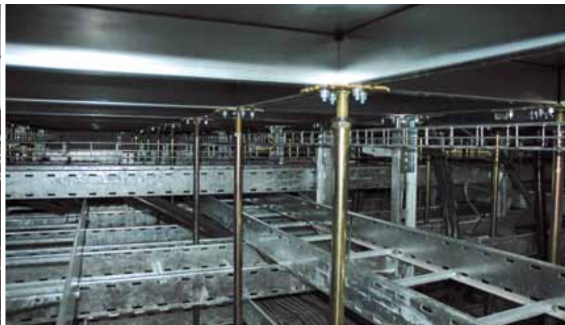
Für Südzucker – Deutschland hat Rowa-Moser eine Doppelboden-Sonderlösung mit im Hohlraum integrierten Kabeltassen, montiert auf Doppelboden-/Kabeltassen-Sonderstützen, realisiert, die kostengünstiger ist und Platzersparnis bietet
